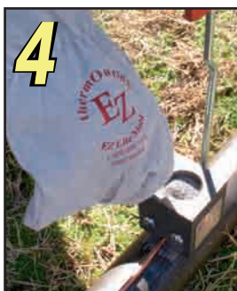
4 Pour weld metal into mold.
