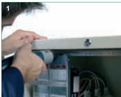
Retirar 2 tornillos de sujeción
