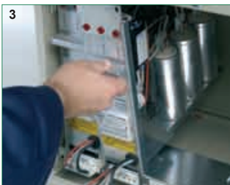
Sacar el módulo a sustituir
