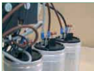
Detalle del mecanismo de desconexión automática y resistencias de descarga de los condensadores.
