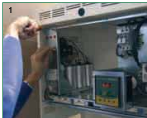
1 Retirar 2 tornillos de sujeción
