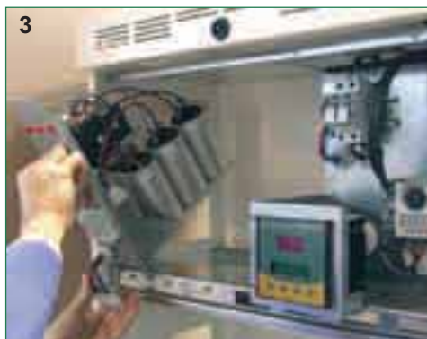
3 Sacar el módulo a sustituir
