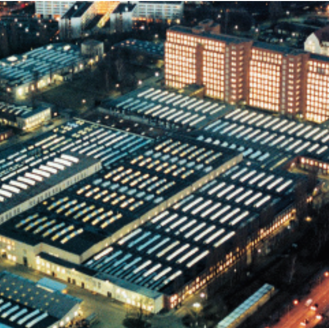
Fábrica de Interruptores Schaltwerk Berlín, Alemania
