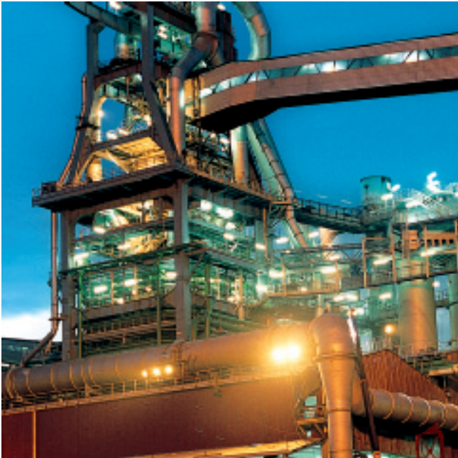
Aplicación industrial: Refinería
