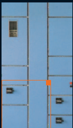
Cuadros de distribución tipo bastidor.
