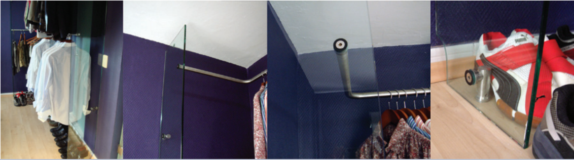
Closet de cristal templado y postes de acero inoxidable.
