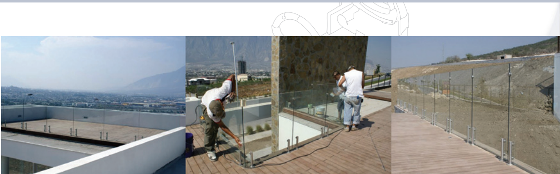
Barandal de cristal templado con postes especiales. Obra: CMG. Monterrey, Nuevo León.
