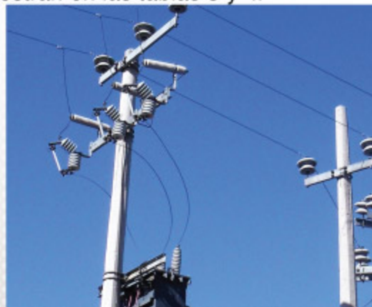
Figura 5: Eslabón fusible protegiendo a Transformador
