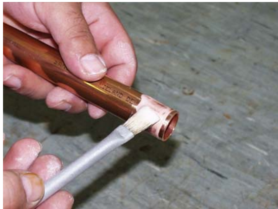
Flußmittel am Rohr auftragen Apply the soldering flux on the pipe Appliquer le fondant au tube
