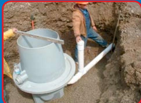
Para asegurar la integridad del sistema, se realizan pruebas de hermeticidad de vacío durante el período de construcción.
