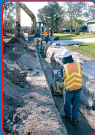
Las líneas de vacío usan tuberías de diámetro pequeño instaladas en zanjas angostas y de poca profundidad. Debido a estos factores, las líneas se instalan típicamente en forma adyacente al pavimento, minimizando la restauración de las calles.
